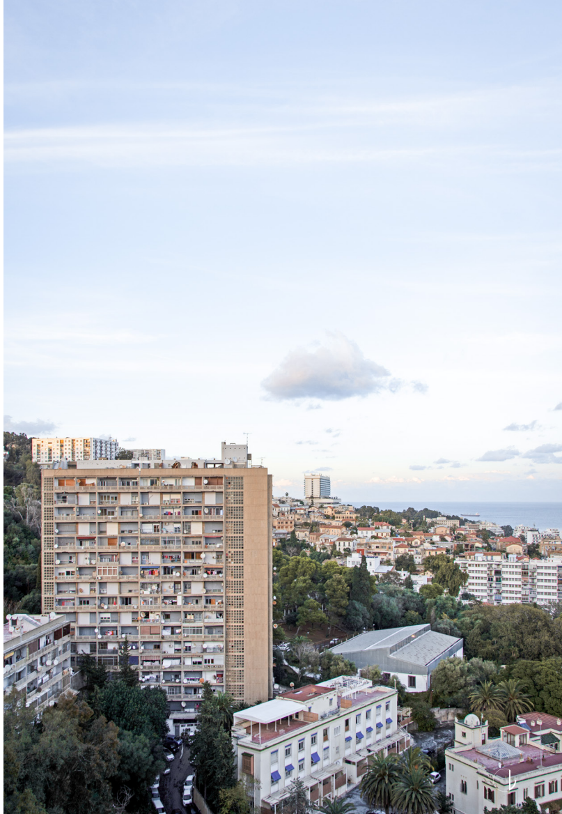
Vue du Télemly, Aéro-Habitat, Alger, 2019
