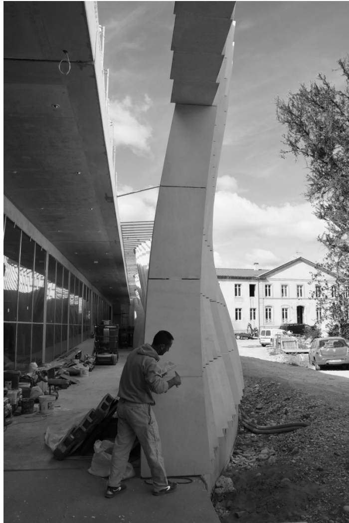
Illustration 11 Artisan en train de reboucher les joints horizontaux du mur pour créer l'effet de verticalité sur le mur.
