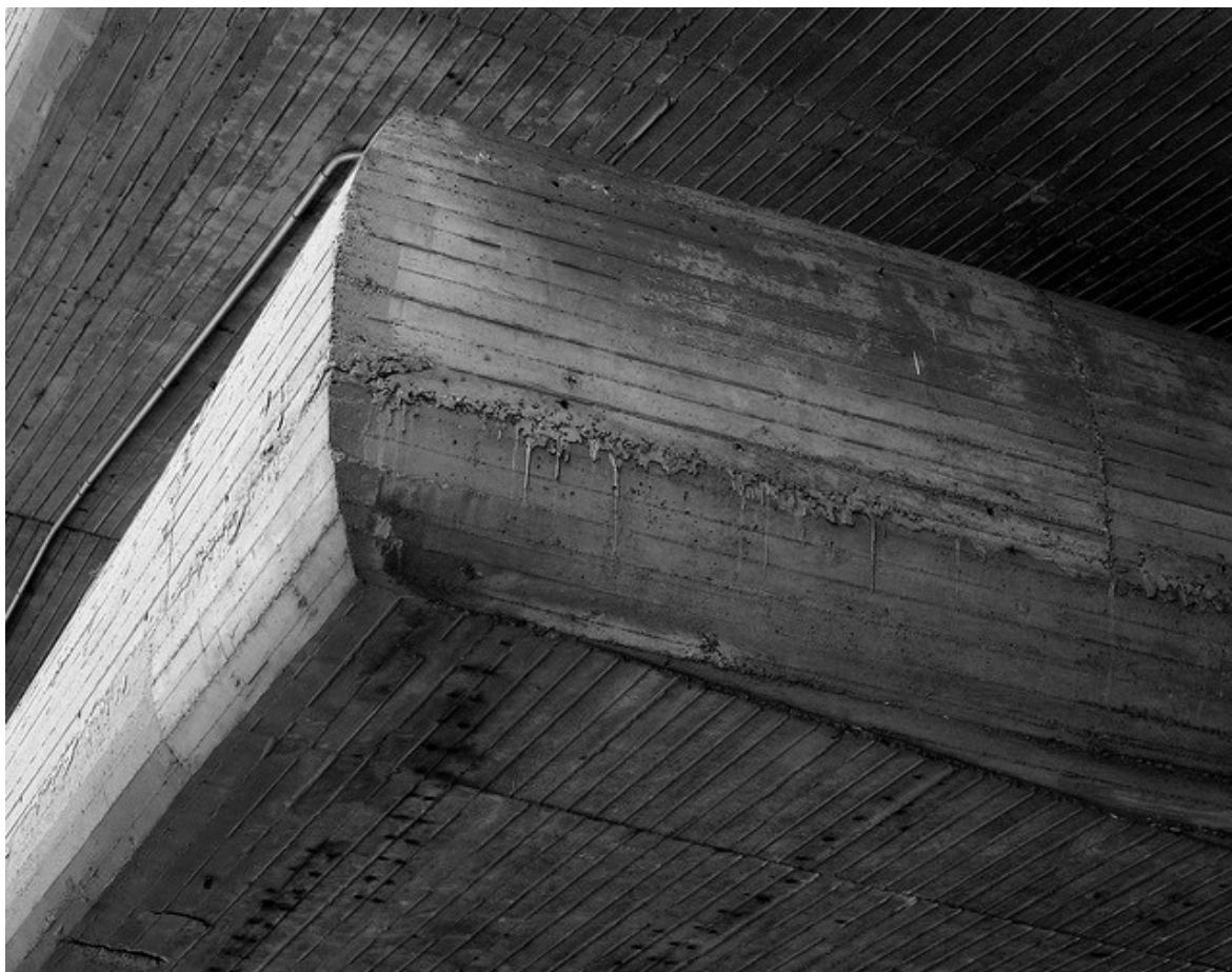
Illustration 12 Banche béton avec coffrage en bois pour la construction du Temple Street Garage de Paul Rudolph.
