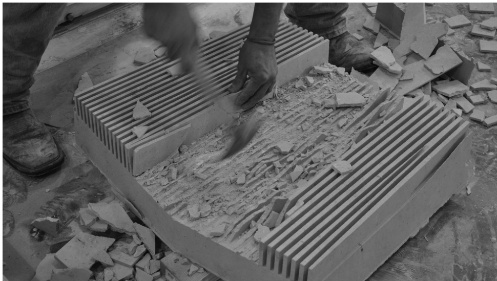
Illustration 16 En haut, Amarillo Vault construit le Block Research Group. En bas, ici l'artisan vient casser à l'aide du marteau les stries de pierre pour former la matérialité intérieure de la voûte.
