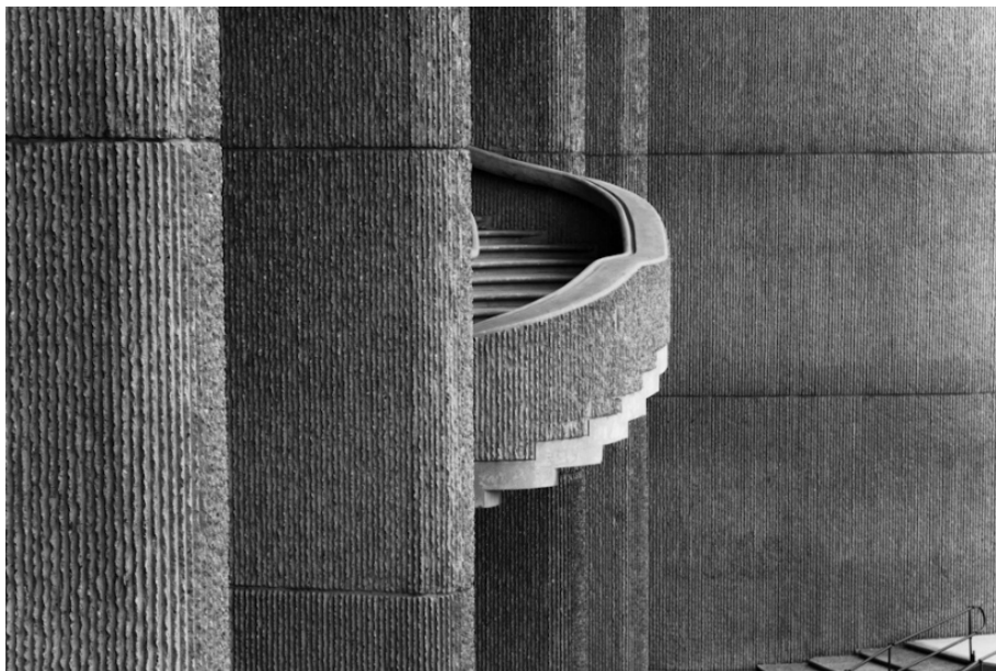
Illustration 14 Boucharde à gauche et à droite un zoom sur la texture du béton de la Yale Art Academy où le béton a été bouchardé.
