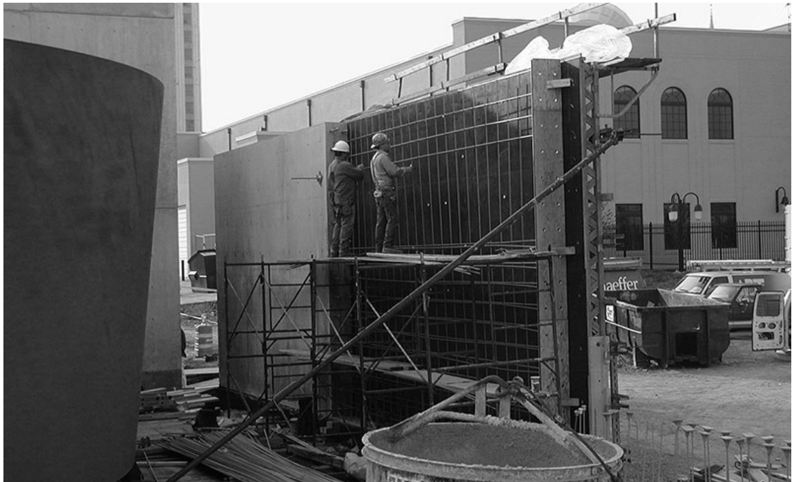
Illustration 7 Construction d'un mur en béton pour la fondation Pulitzer de Tadao Andô.
